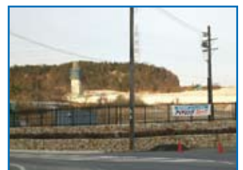
▲新ごみ処理場(建設中)
